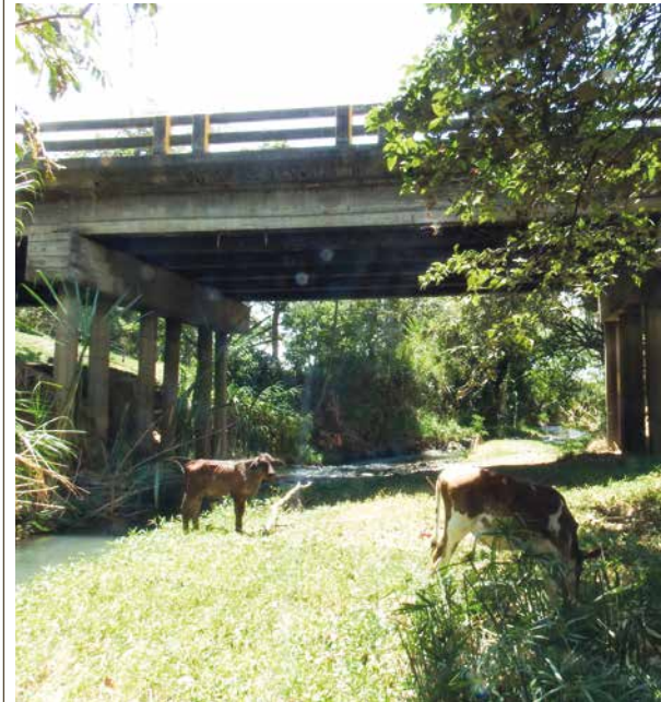
Figura 25: Viaducto que minimiza la intervención en el cuerpo de agua dando continuidad a los hábitats terrestres. Fuente: Darío Correa Quiñones.
