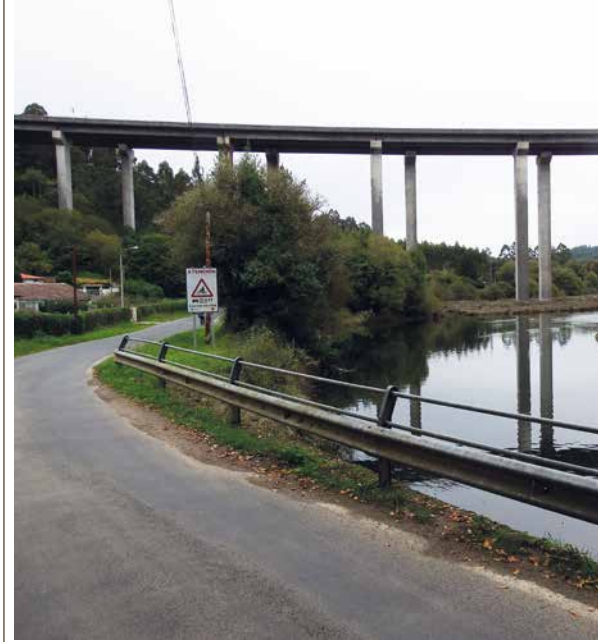
Figura 28: Viaducto sobre el río Lambre (Galicia, España) que minimiza la intervención en los ecosistemas y en el cauce. Fuente: Darío Correa Quiñones.
