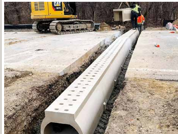
Figura 53: Paso de anfibios, con estructura de guía en embudo. Fuente: Ministerio de Agricultura, Alimentación y Medio Ambiente - España, 2015.
