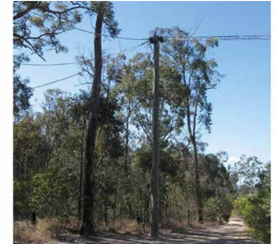
Figura 13: Cuerdas conectando un puente de dosel a los árboles cercanos por fuera del derecho de vía. Fuente: Department of Transport and Main Roads, 2010.
