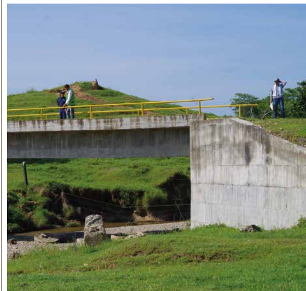
Figura 33: Puente con pilas fuera de la ronda, dejando libre el paso de fauna terrestre y sin intervención el cauce. Fuente: Darío Correa Quiñones.
