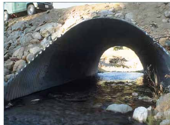
Figura 59: Uso de una alcantarilla de sección abierta, para minimizar la intervención del cauce. Fuente: Keller & Sherar, 2004.
