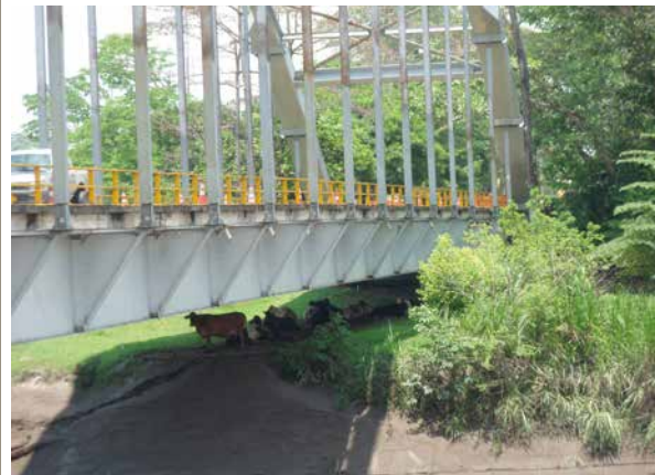
Figura 60: Puente en la Ruta del Sol, con el cauce libre de intervención. Fuente: Darío Correa Quiñones.
