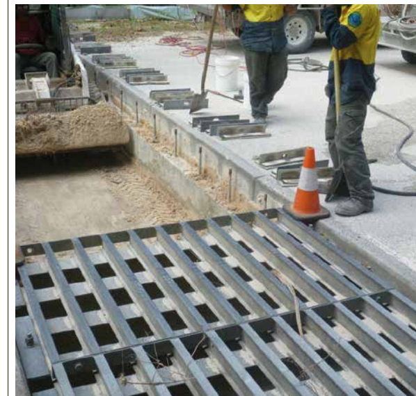
Figura 55: Mantenimiento de una alcantarilla superficial de gran tamaño, diseñada para paso de cangrejos en Christmas Island, Australia. Fuente: https://www.christmas.net.au/20km-of-barriers-31-underpasses-and-1-bridge-getting-ready-for-the-great-crab-migration/
