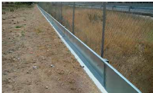
Figura 69: Estructura opaca de metal para guiar a la fauna más pequeña hacia el paso seguro. Fuente: Ministerio de Agricultura, Alimentación y Medio Ambiente, 2015.
