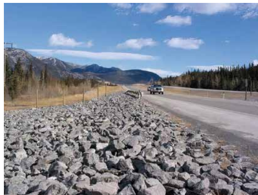
Figura 71: Lecho de piedras utilizado como cambio de sustrato al final de la barrera. Fuente: Federal Highway Administration - U.S. Department of Transportation, 2011.
