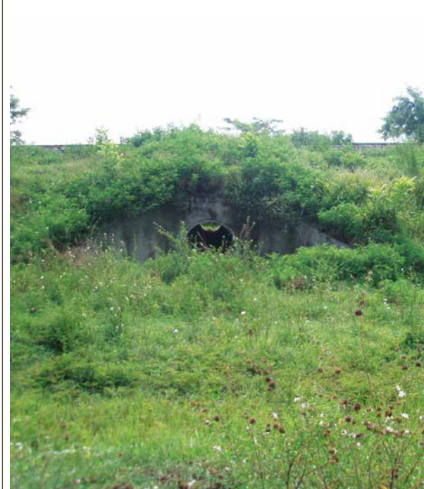
Figura 46: Alcantarilla para fauna pequeña, con recuperación de la vegetación circundante. Fuente: Darío Correa Quiñones.
