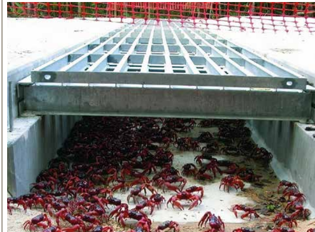
Figura 52: Alcantarilla superficial para paso de cangrejos en Christmas Island, Australia. Fuente: Tomada de Internet: https://www.planetcustodian.com/important-wildlife-corridors-world/12788/
