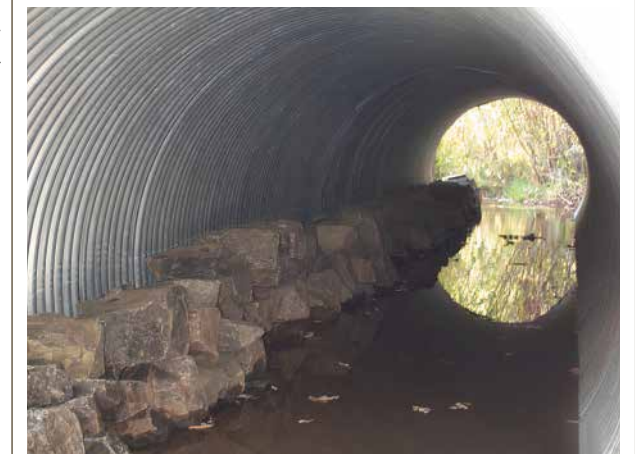
Figura 55: Mantenimiento de una alcantarilla superficial de gran tamaño, diseñada para paso de cangrejos en Christmas Island, Australia. Fuente: https://www.christmas.net.au/20km-of-barriers-31-underpasses-and-1-bridge-getting-ready-for-the-great-crab-migration/
