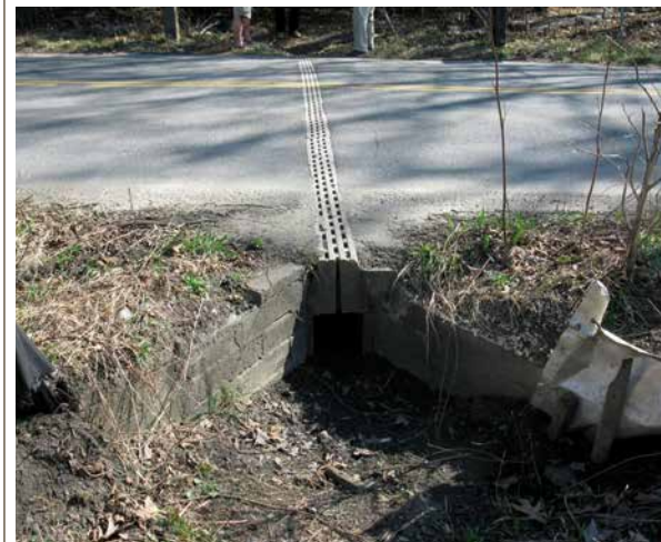
Figura 54: Túnel para salamandra moteada ( Ambystoma maculatum ), con 25 años de funcionamiento. Fuente: https://acoswm.com/the-first-wildlife-tunnel/
