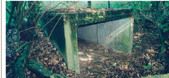
Figura 41: Box de 1m de alto, con pasarelas a ambos lados, en cercanías del SSF Los Colorados (San Juan de Nepomuceno, Bolívar). Fuente: Darío Correa Quiñones.
