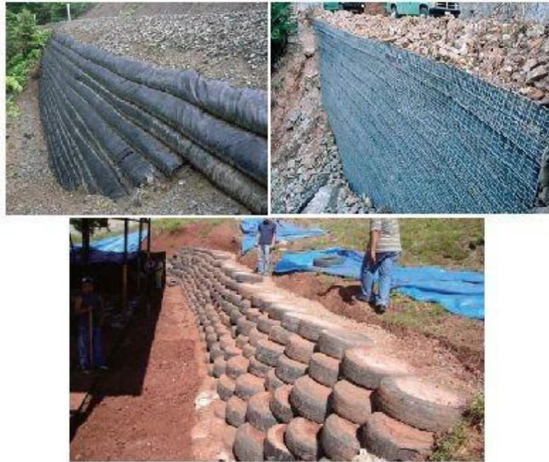
Figura 5 Muros de contención con diversos materiales.
